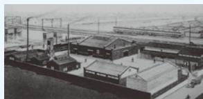
鳴野工場全景
